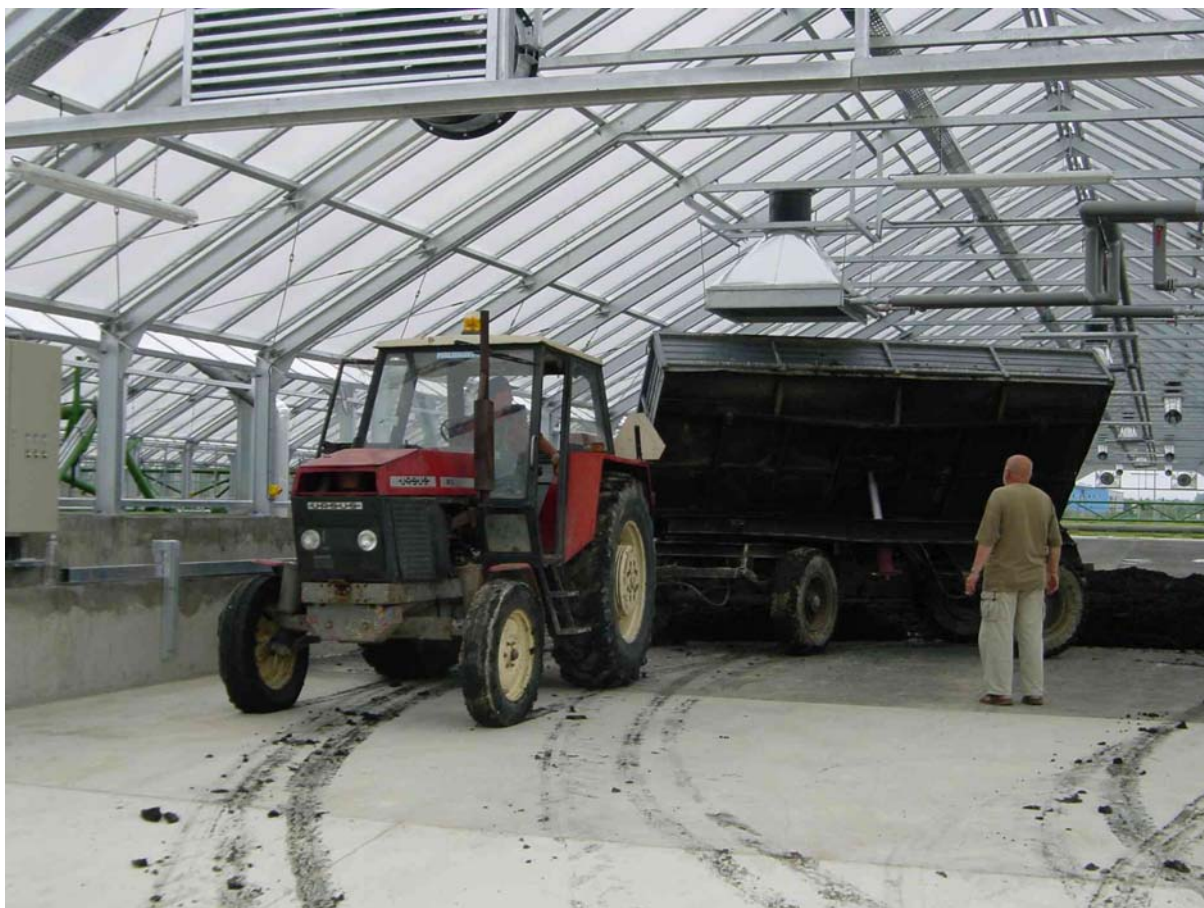
Zdjęcie 6: Dowóz świeżego osadu podczas rozruchu technologicznego obiektu
