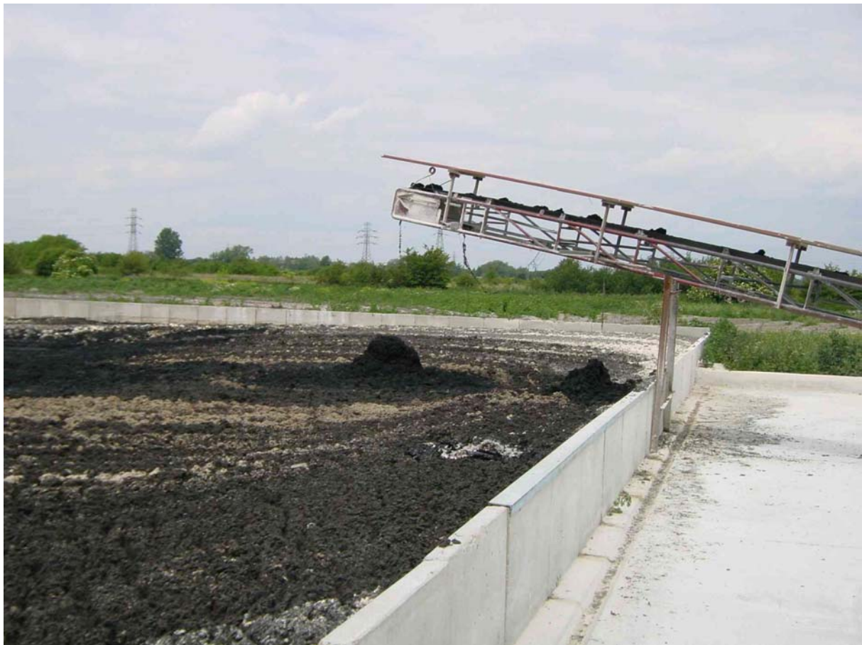
Zdjęcie 2: Składowisko mechanicznie odwodnionego osadu, skąd trafia on do suszarni słonecznej
