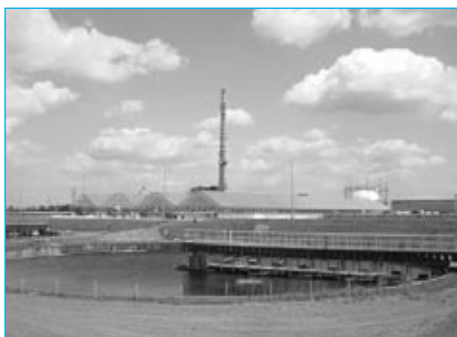
Fot. 1. Suszarnia osadów ściekowych na oczyszczalni ścieków w Rzeszowie
