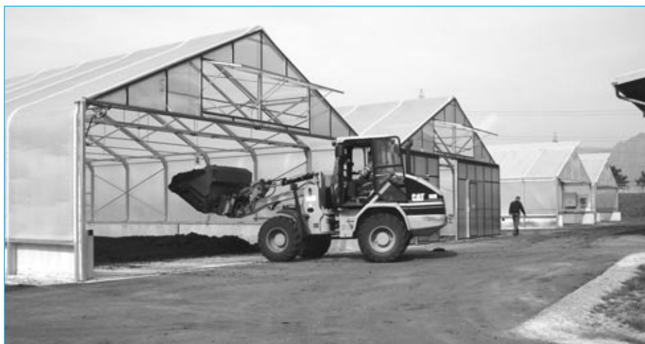
Fot. 2. Dowóz mechanicznie odwodnionych osadów do suszarni.
